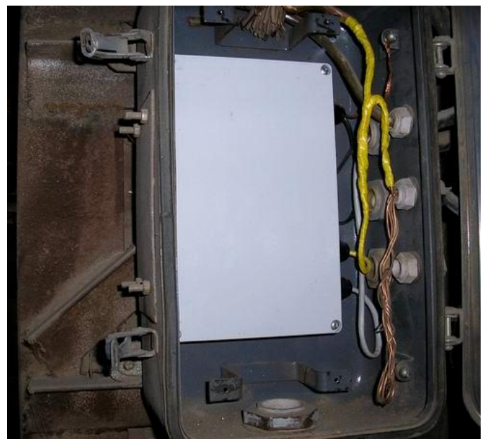
Пример монтажа блока БСУ в надсилосном этаже.
